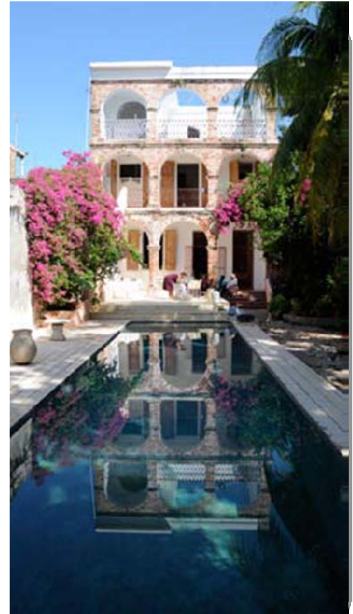
Maison de Jacmel détruite par le séisme – Photo ISPAN 2009
